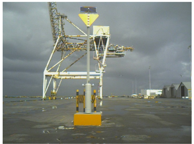
North Quay West (Berth #2) Rear
